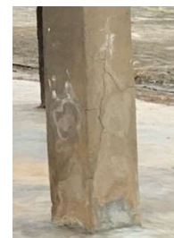
รูปที่ 3.2 คราบขาวลักษณะคล้ายเกลือบบริเวณผิวหน้าคอนกรีต
