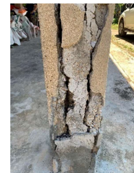
รูปที่ 3.1 ลักษณะการวิบัติของเสาคอนกรีตเสริมเหล็ก
