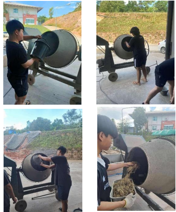
รูปที่ 5 การผสมคอนกรีตโดยเครื่องโม้
