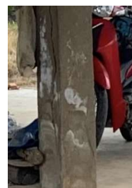
รูปที่ 3.2 คราบขาวลักษณะคล้ายเกลือบบริเวณผิวหน้าคอนกรีต
