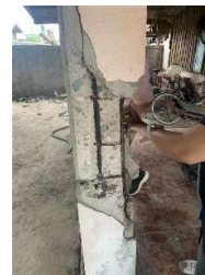
รูปที่ 3.1 ลักษณะการวิบัติของเสาคอนกรีตเสริมเหล็ก
