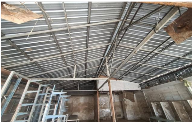
รูปที่ 4 ภาพความเสียหายระดับความเสียหายปานกลาง
