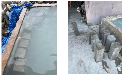
รูปที่ 9 การบ่มคอนกรีต
