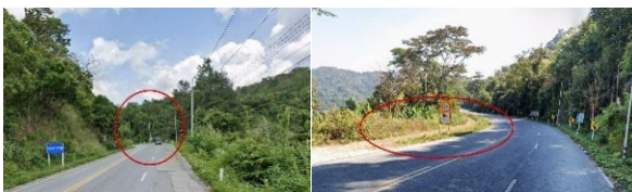
รูปที่ 4.7 ไม่มีการติดตั้งราวกันตกและการติดตั้งไฟฟ้าส่องสว่างที่เพียงพอ
