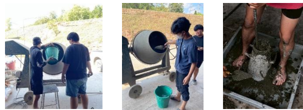
รูปที่ 7 ขั้นตอนการผสมคอนกรีต
